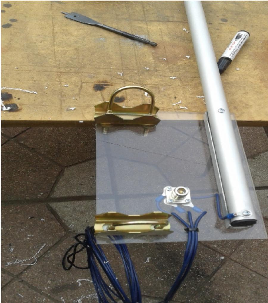
En este punto solo se debe montar las abrazaderas en los orificios previamente hechos esto dará soporte a la antena en el mástil una vez montada.
