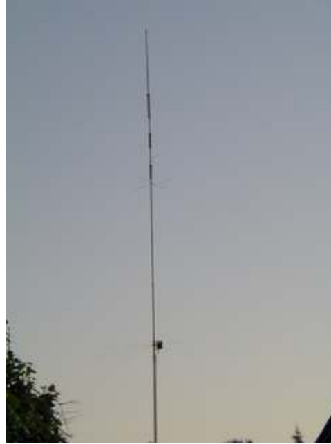
Vista antena multibanda 40, 20, 10 y 15 m.
